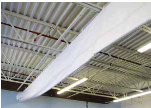
給気停止時のスケールコアシステムの“しぼみ”のない状態
