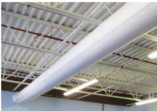
給気停止時のスケールコアシステムの“しぼみ”のない状態
