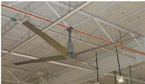
BladeTec 最大特色，就是壓倒性的大風量。每一個葉片產生的風量遠勝其他品牌，4 個葉片雖然旋轉速度不快，但卻能吹出令人感到舒服的大風。分成適合物流倉庫和工廠等的 INDUSTRIAL（齒輪馬達），以及能設置在靜音環境的 COMMERCIAL（直驅馬達）2 款機種，可以依據空間大小，選擇尺寸符合需求的風扇。
